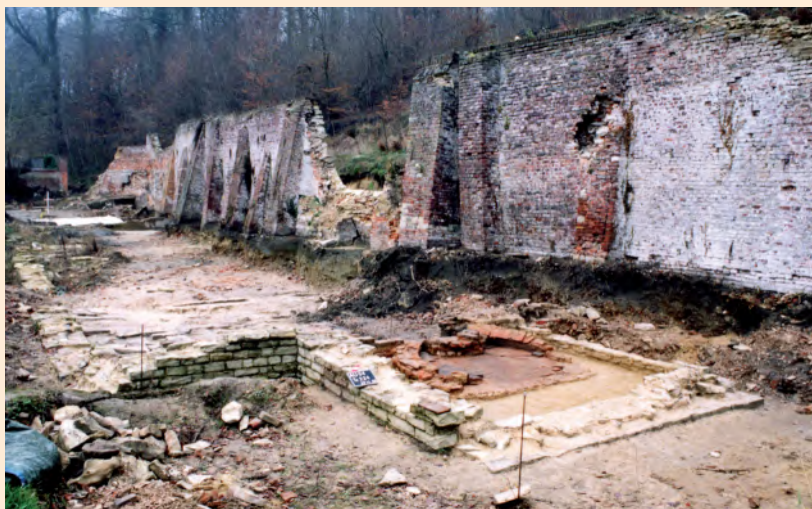
95. Seul la façade méridionale de la brasserie, faisant office de mur d'enceinte fut préservée. À l'avant-plan, le support de cuve installé dans un édicule (© MRBC-DMS, photo S. Modrie, novembre 2003).
