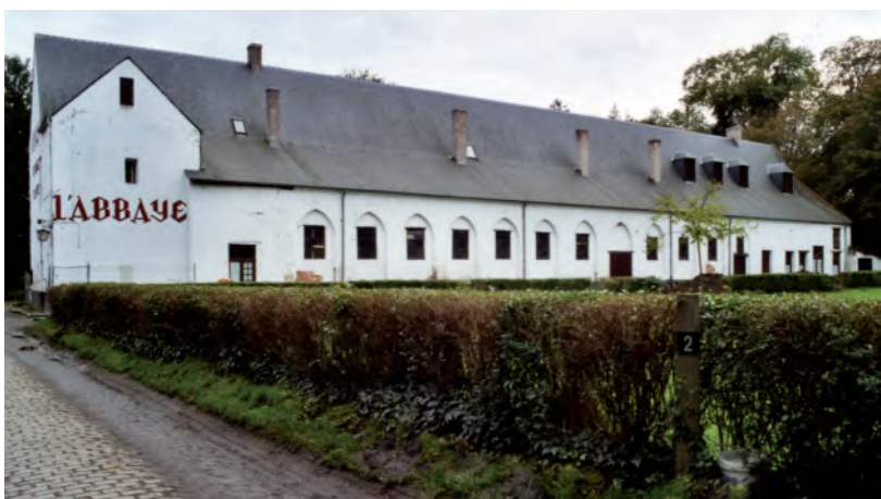
69. Façade nord-ouest de la maison du prieur (© MRBC-DMS, photo S. Modrie, 2000).
