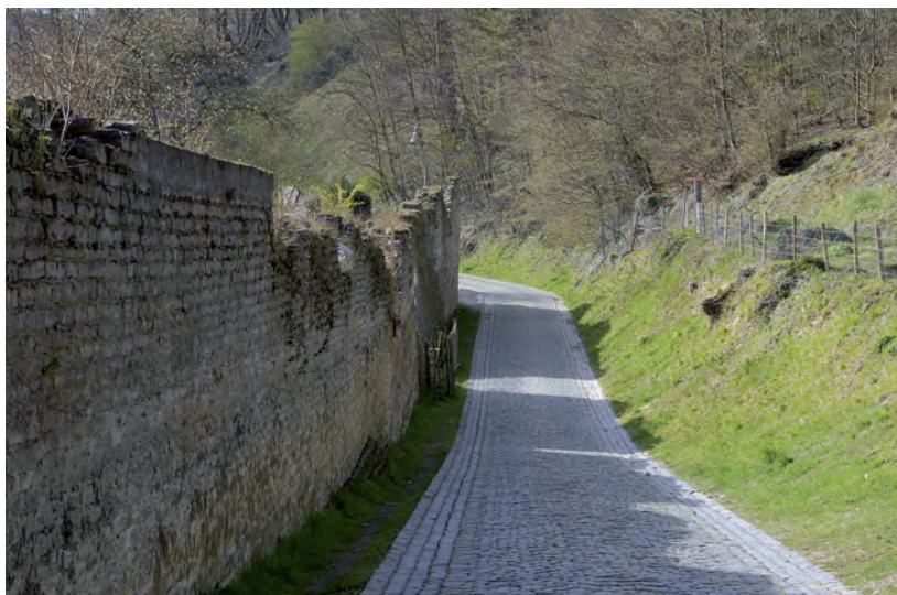
81. L'enceinte extra-muros (© X. Claes / Soleil Rouge, 2008).
