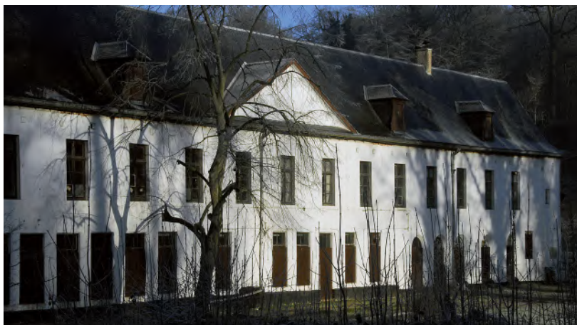
68. Façade sud-est de la maison du prieur (© X. Claes / Soleil Rouge, 2009).
