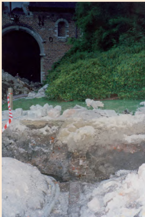
44. Tranchée ouverte près de l'ancien quartier agricole (photo Ch. Clauss, 2001).
